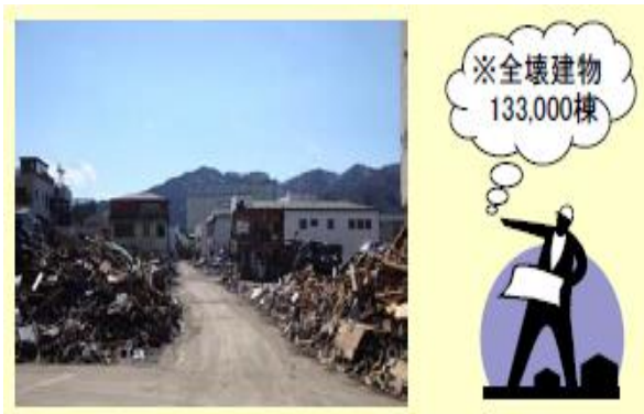
図表 3-2-8 倒壊した建物の集積状況
