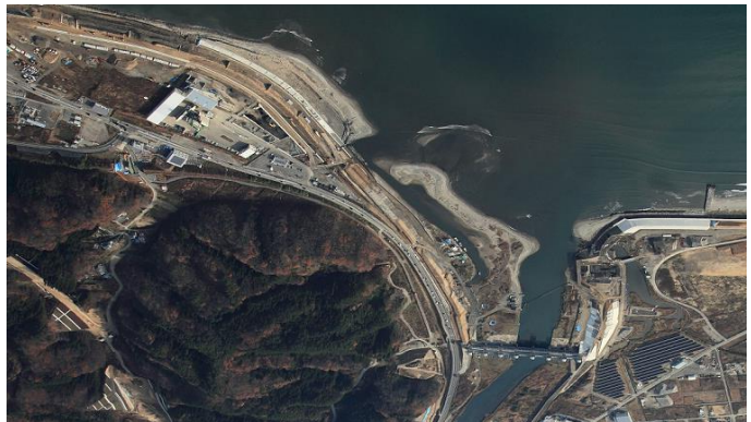
緊急使用箇所（工事中）
