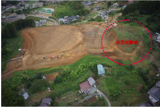
図表 3-2-40 赤崎小学校建設予定地（着工前）
